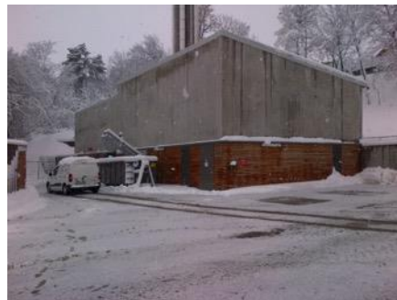
La chaufferie du centre hospitalier en plein hiver.
